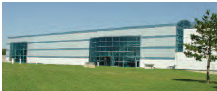
Planta de tratamiento de agua
