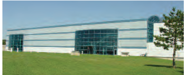
Planta de tratamiento de agua
