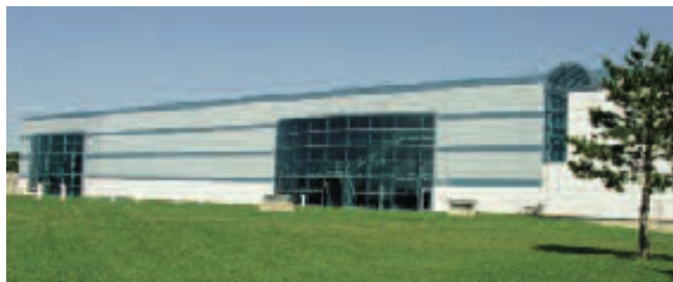
Planta de tratamiento de agua
